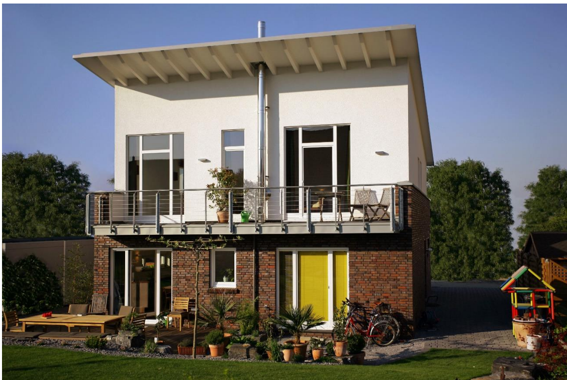
Ein nachträglich installierter Edelstahlschornstein kann für alle Feuerstätten genutzt werden
